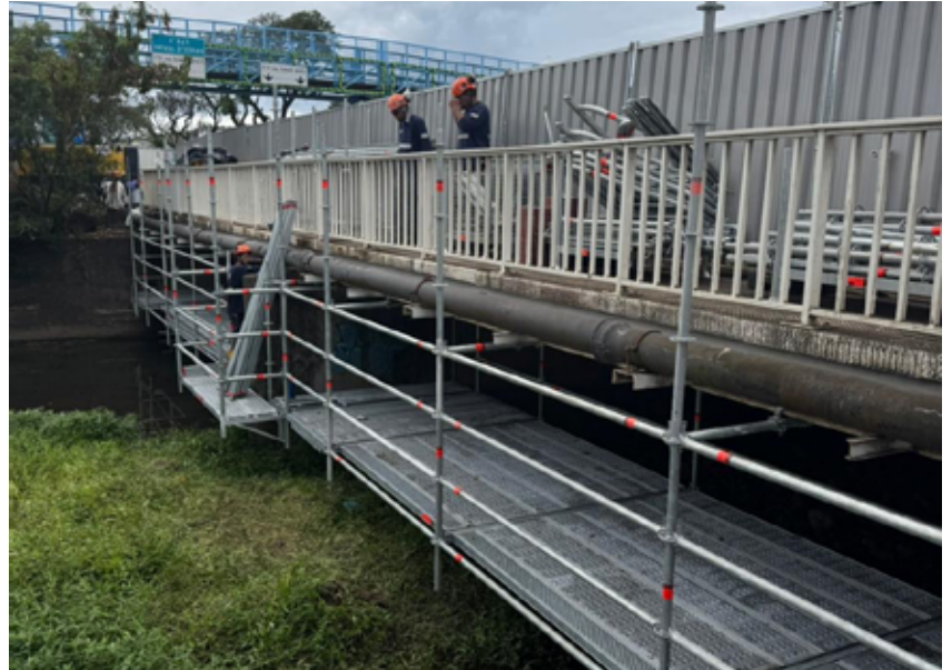
Échafaudage suspendu - Anticorrosion - Passerelle de Tipaerui.
